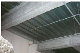
鉄骨耐火被覆施工例
